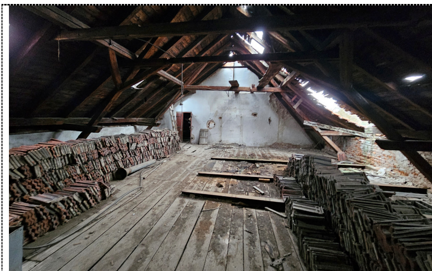
Obr. 20: Výroba – krov, poškozený / havarijní strop
