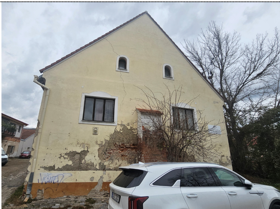
Obr. 8: Štítové zdivo administrativy. Trhlina procházející celým štítem.
